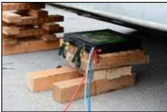
Slika 5.2: Postavitev dvizne blazine SAVA na mesto dviga
